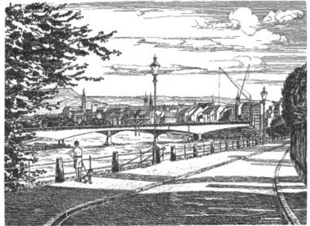
Johanniterbrücke im Umbau 1966-67.
