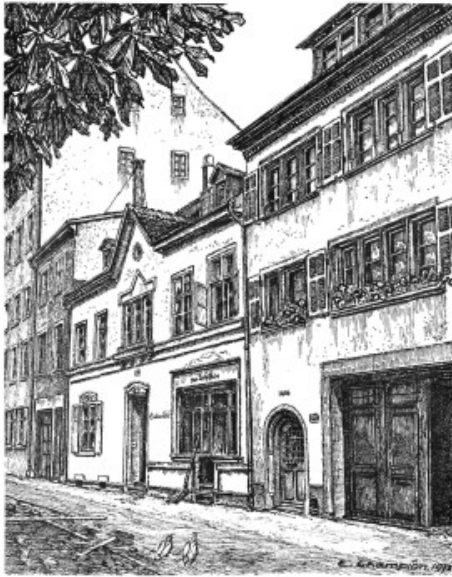
Restaurant zum Letztbühl im St. Albantal Bauplatz für den "Goldenen Stenov"
